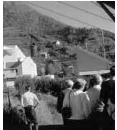
Die Seilbahn mit der runden Gondel, die anlässlich des Baues der Kraftwerkzentrale in Kompatsch um 1960 errichtet und in der Zwischenzeit wieder entfernt wurde. (Aufnahme Adolf Fliri)
