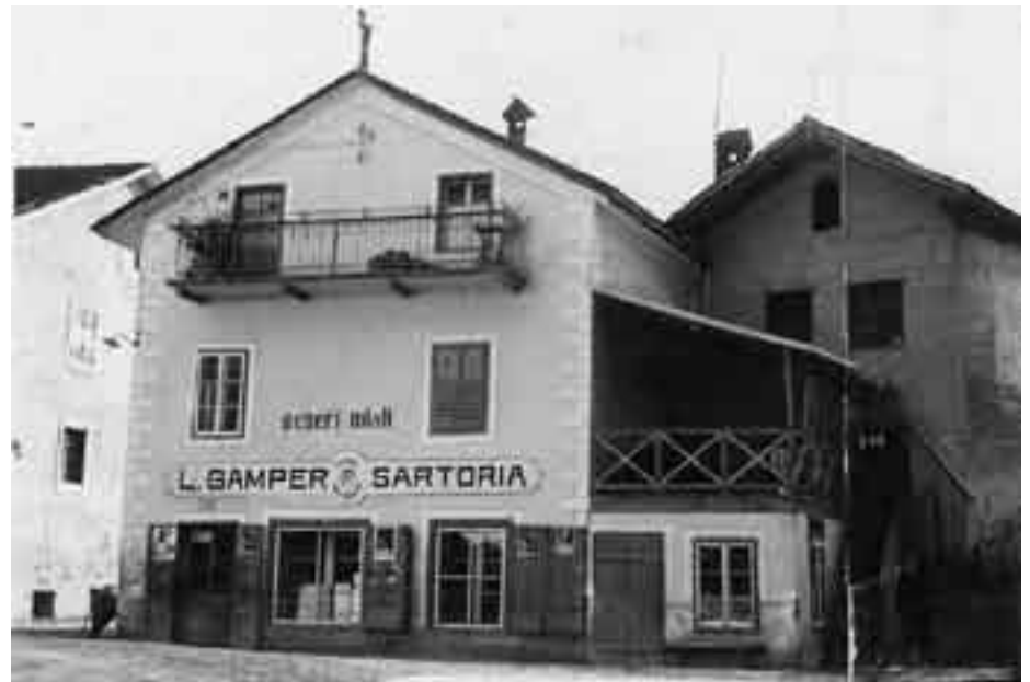
Ansicht des sog. Maschlerhauses um das Jahr 1930 (lt. Tarneller: Schlosserhaus), heute Parkplatz für das Hotel Lamm, links das Köchelhaus. (Familienarchiv Hedi Gamper Stompe)
