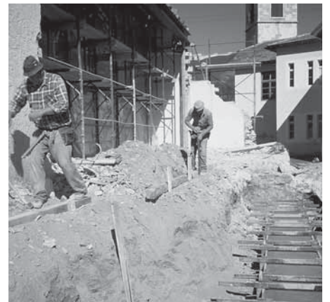
August 1990 Umbau Probelokal
