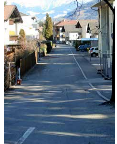
Für die Sanierung der Etschangerstraße stehen nochmals 264.000 Euro zur Verfügung.
