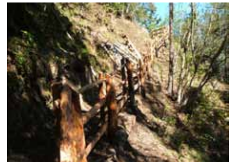
Ein Teil des fertiggestellten Holzzaunes.
